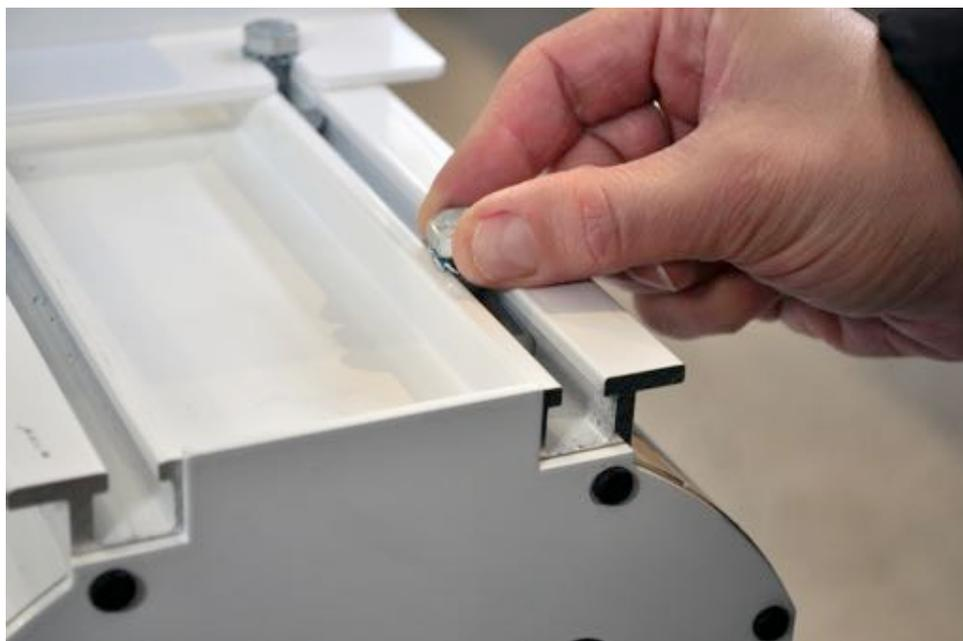
A questo punto, inserire nelle scanalature presenti sulla parte superiore del cassonetto due set costituiti da dado a slitta, rondella zigrinata e vite a testa esagonale ciascuno, per ogni piastra di ancoraggio.
